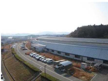
左は、放射光を発する電子蓄積リングが入っている蓄積リング棟。の外観の一部。三原栗山の中腹をこの様に一周する巨大な施設である。蓄積リングの基礎は岩盤に直接つながり、周囲の床・壁・天井等とは切り離されていることで地表の振動の影響を受けないようになっている。
